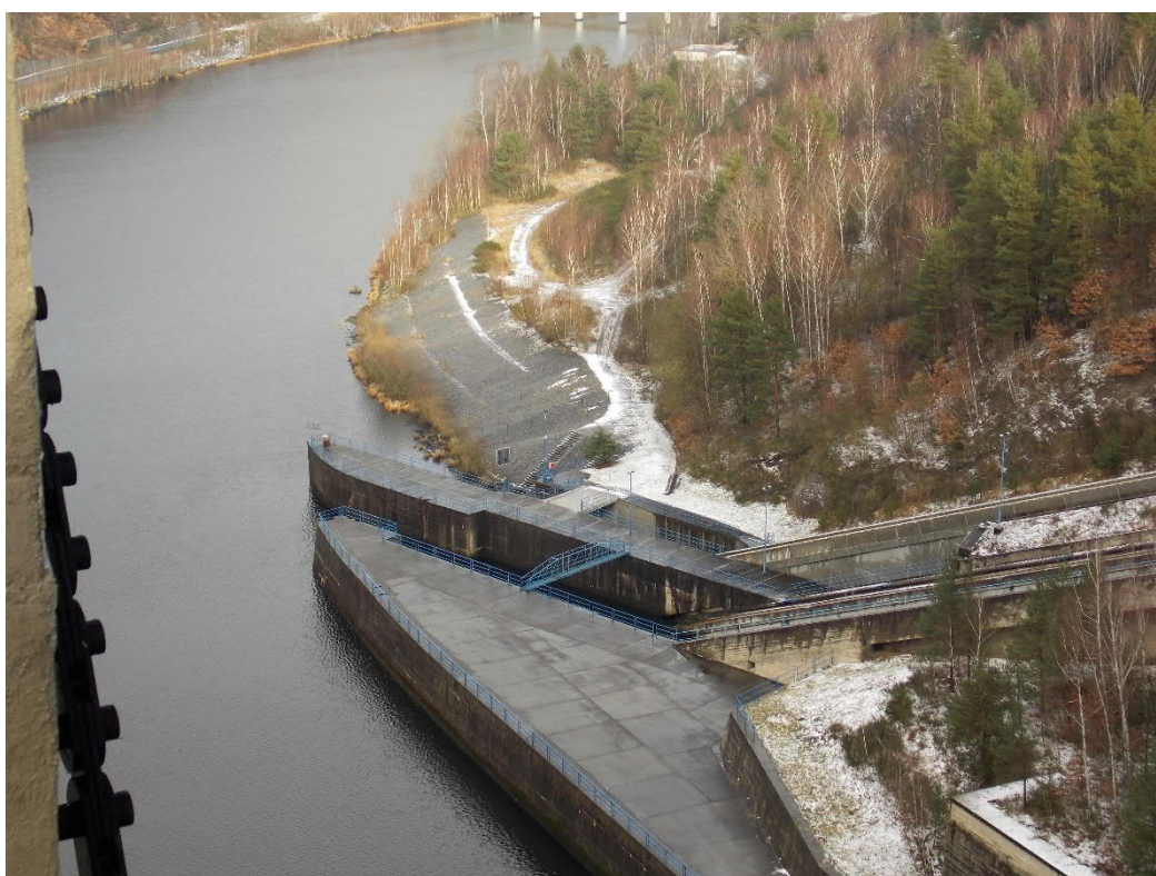
Obr.4 – V prostoru vpravo od lodního zdvihadla bude umístěna otevřená část skluzu
